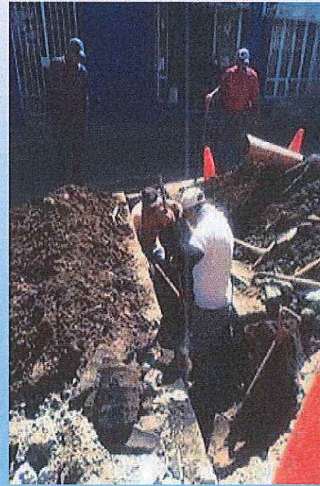
Rehabilitación de descargas domesticas en distintos puntos de la ciudad
