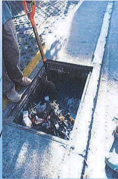
Desazolve de rejilla en José Ma. Coss Ote 2
