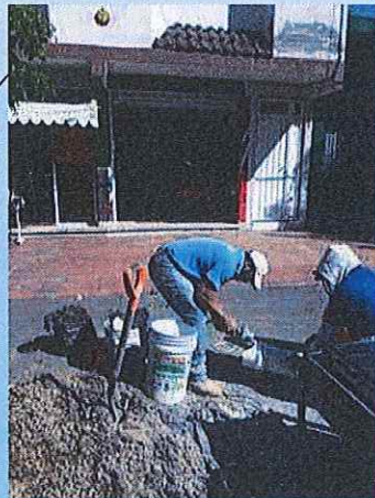
Reparación de fuga en líneas de asbesto de 6" en la calle Hidalgo Ote. 208.
