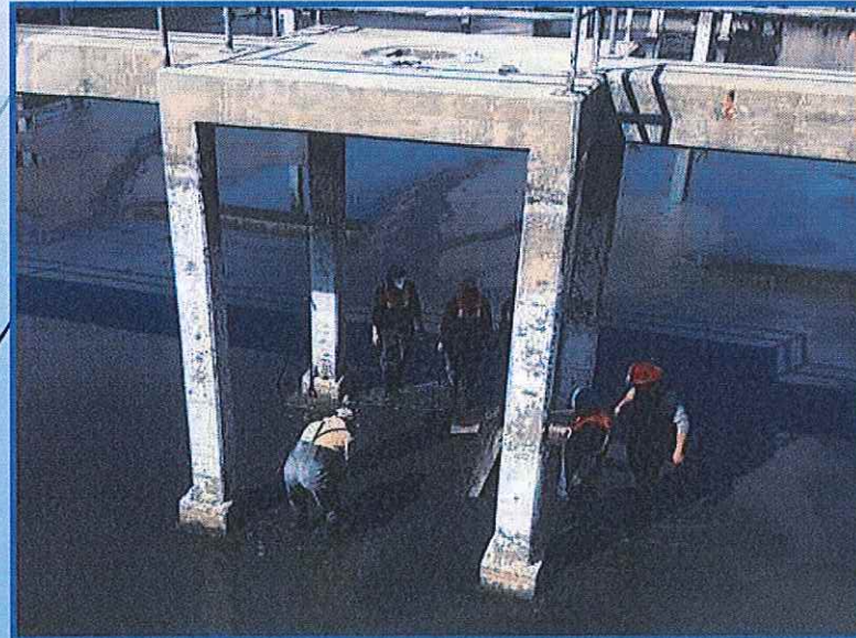
Desmantelamiento de propelas del Tanque de Aereación 2
