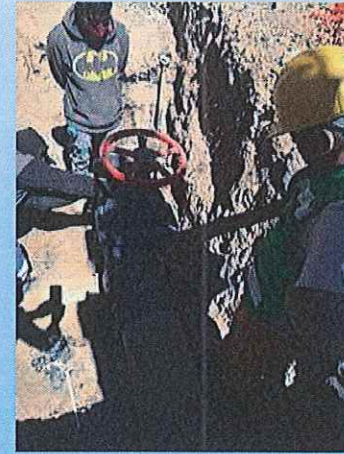
Colocación de 2 válvulas de 10" en la calle Salazar Sur entre Sixto Verduzco y Av. Revolución Sur
