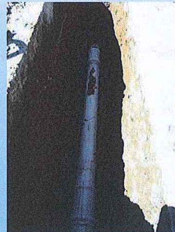
Reparación de fuga en línea de PVC de 6" en la calle Lago de Pátzcuaro 246.
