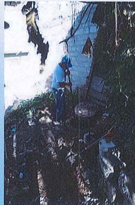
Sondeo a drenaje general y desazolve de pozos de visita por obstrucción en Av. Cd. de la independencia.
