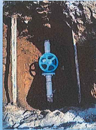
Colocación de válvula de 2" en la calle Lago Mitla 100
