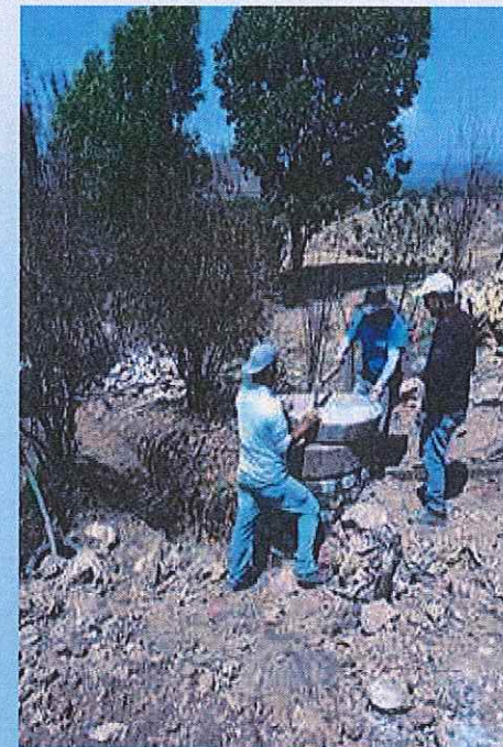
Nivelación de pozos de visita en la calle Lerdo de Tejada Pte.
