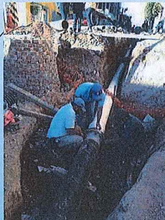
Rehabilitación de línea de 10" de asbesto a PVC en la calle Salazar Sur, de Sixto Verduzco a Av. Revolución Sur
