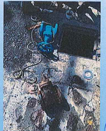
Cambio de válvula de 3" en la entrada al Fraccionamiento Villa Bonita
