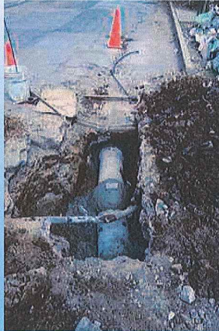
Inspección y rehabilitación de drenaje general por hundimiento en Av. La Palma.
