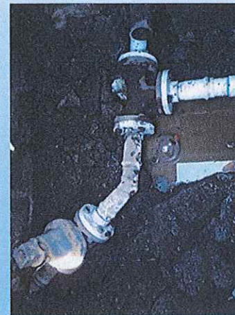
Cambio en la colocación de la válvula de 2" en registro sobre Patio del Ferrocarril S/N
