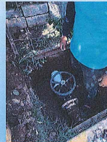
Cambio de válvula de 4" en Andador Margarita en el Infonavit
