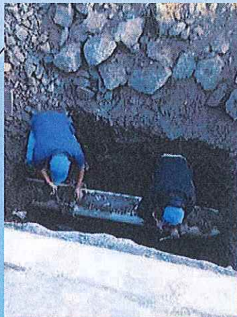
Reparación de 1er fuga en línea de asbesto de 12" en la Av. Revolución Sur, ocasionada por trabajos de remodelación. (esquina con Agustín Melgar)
