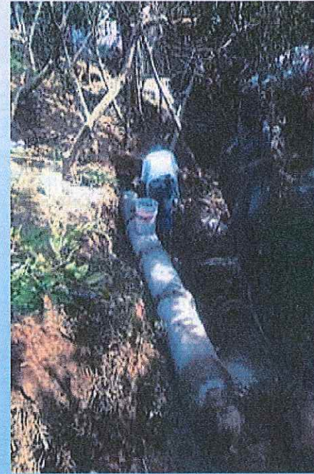
Rehabilitación de drenaje general en la calle Jacarandas 2
