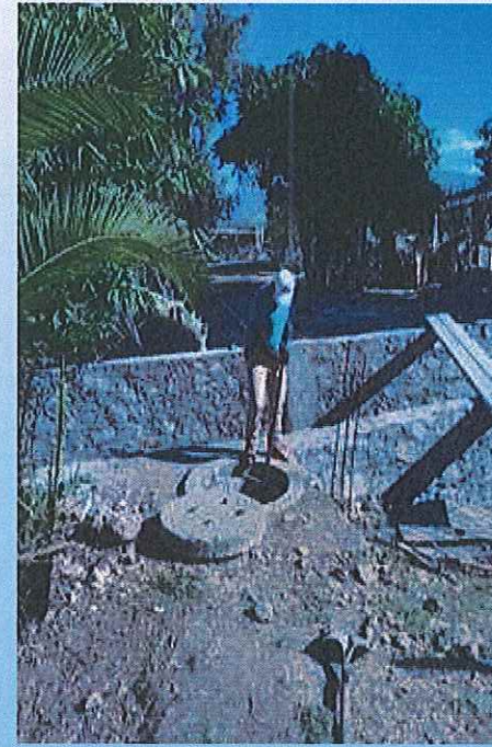
Desazolve de pozos de visita en distintos puntos de la ciudad
