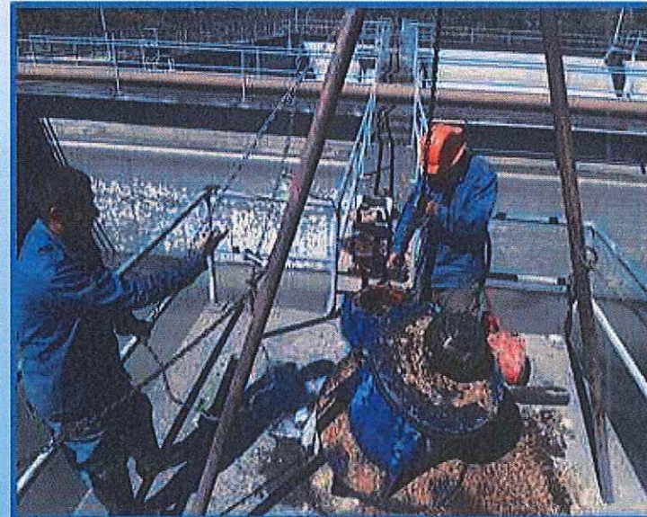
Desmantelamiento de equipos del reactor biológico
