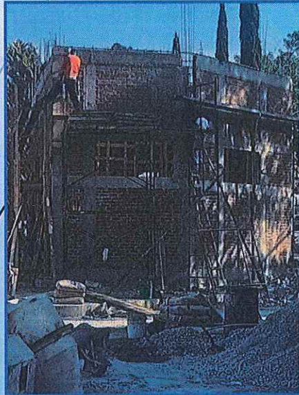
Construcción de Caseta de Sopladores
