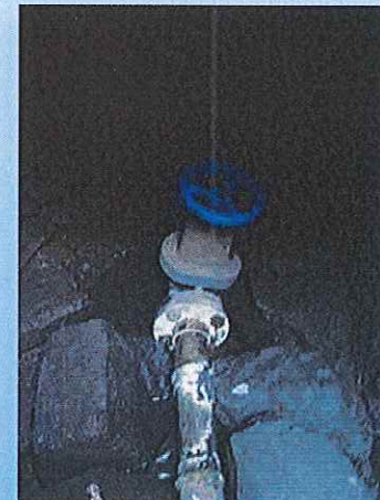
Cambio de válvula de 2" en la calle Lago Azul esquina con Laguna Verde.
