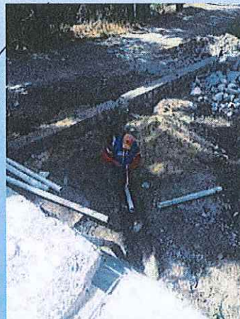
Modificación de la tubería de llenado del tanque de almacenamiento El Paraíso
