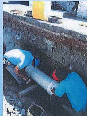
Reparación de 2da fuga en línea de asbesto de 12" en la Av. Revolución Sur, ocasionada por trabajos de remodelación. (frente a la agencia FORD)
