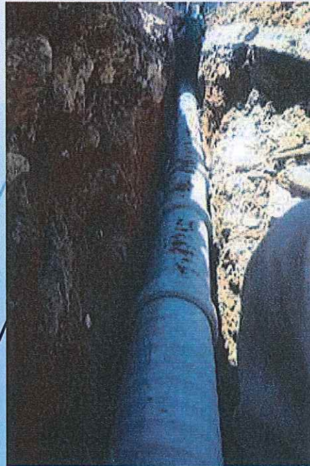
Rehabilitación de drenaje general colapsado en la calle Lago de Chapultepec
