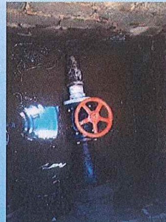
Cambio de válvula de 3" en la calle Altamirano Nte., esquina con Sixto Verduzco.
