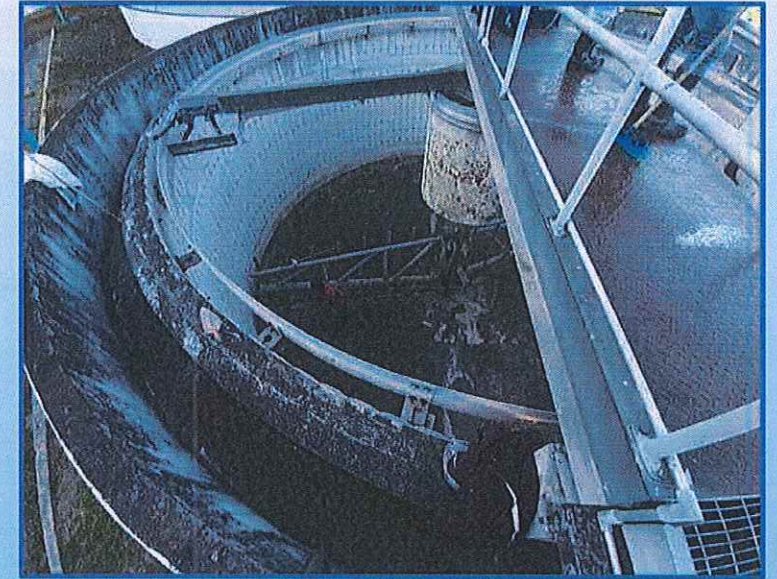
Limpieza del Espesador A
