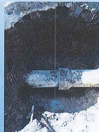
Reparación de 3er fuga en línea de asbesto de 12" en la Av. Revolución Sur, ocasionada por trabajos de remodelación. (esquina con Agustín Melgar)
