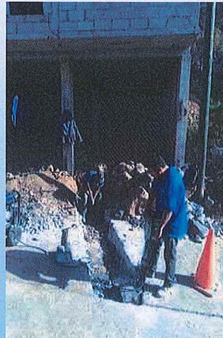
Conexión de descargas domesticas nuevas en distintos puntos de la ciudad
