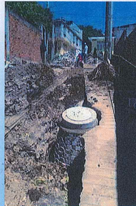
Construcción de pozo de visita en la calle Lago de Chapultepec
