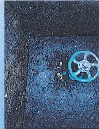
Reparación de fuga en registro de la válvula de 3" en la calle Héctor Terán, esquina con Morelos Sur
