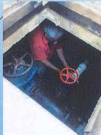
Cambio de válvula de 3" en las instalaciones del tanque de almacenamiento "El Cerrito".
