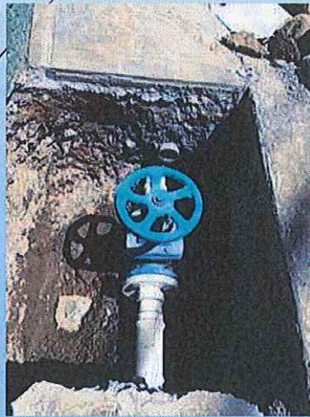
Cambio de válvula de 2" en Av. La Palma 18
