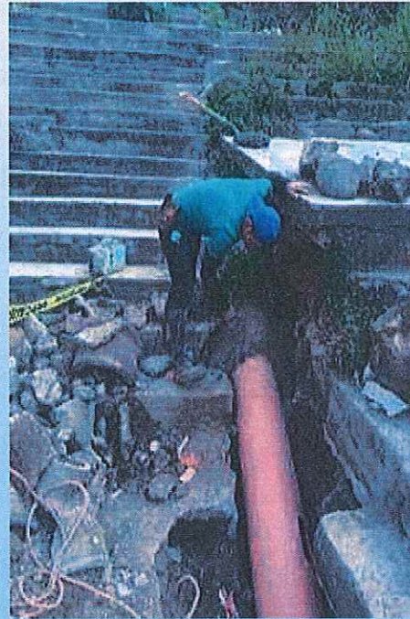
Rehabilitación de drenaje general en la calle pípila Sur esquina con Artillería Pte.
