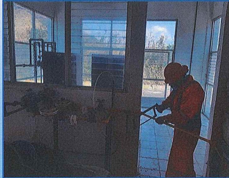
Desmantelamiento de los equipos de cloración
