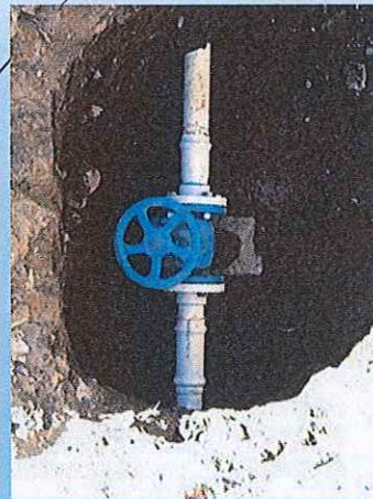
Colocación de válvula de 2" en Patio del Ferrocarril S/N
