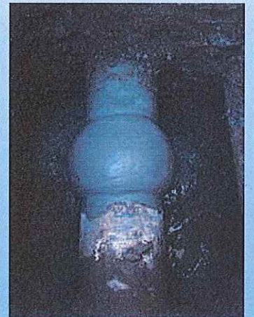
Reparación de fuga en línea de conducción de asbesto de 8" en la calle Salazar Sur esquina con Sixto Verduzco
