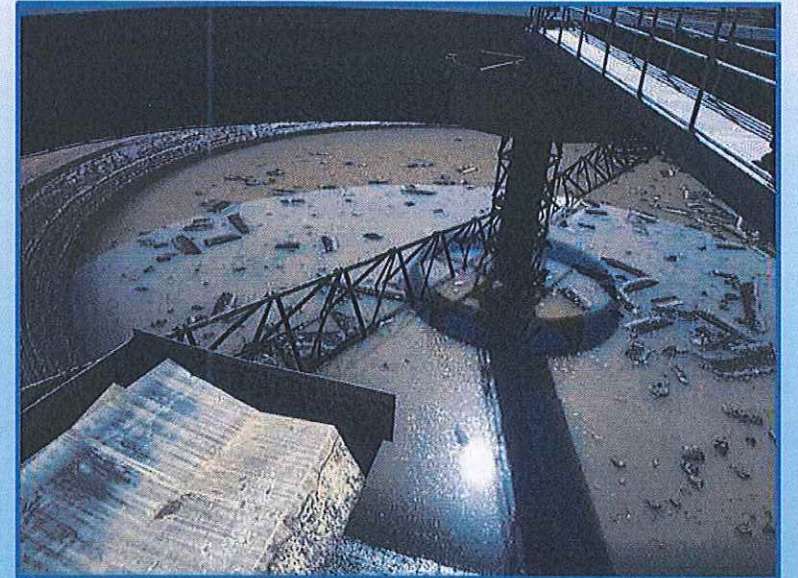
Limpieza y desazolve del tanque Sedimentador B
