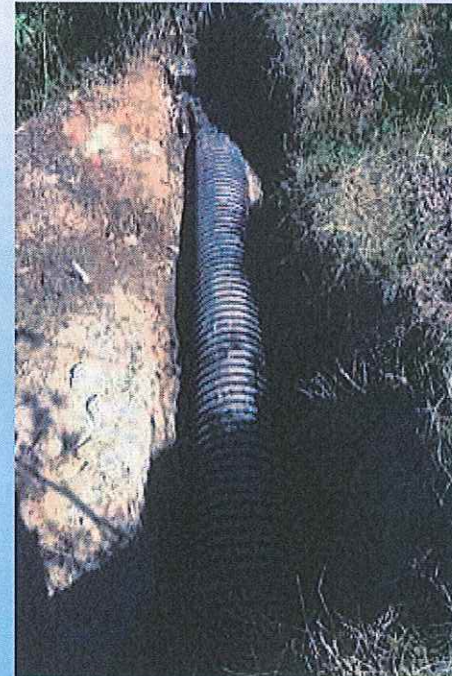
Trabajos de rehabilitación de tubería de 26" del Colector Sur
