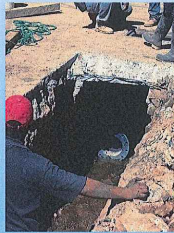
Colocación de 2 válvulas de 10" en la calle Salazar Sur entre Sixto Verduzco y Av. Revolución Sur
