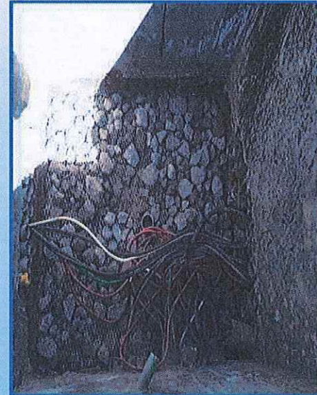
Rehabilitación de registros eléctricos y colocación de filtros con drenes
