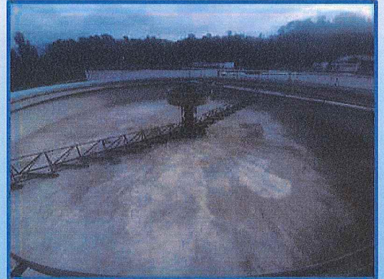
Limpieza y desazolve del tanque Sedimentador A
