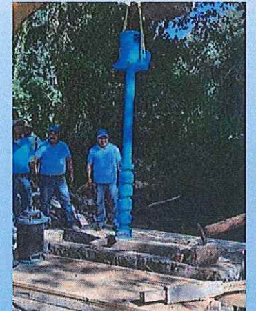
Instalación de equipo de bombeo y habilitación de cárcamo para bombeo de agua de riego en Camembaro
