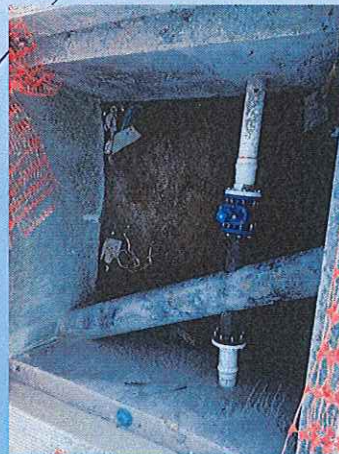
Colocación de 1 válvula de 3" en la calle Av. Revolución Sur esquina con Salazar Sur
