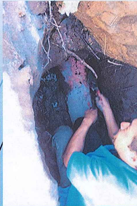
Rehabilitación de drenaje general en la zona industrial frente a la empresa Sello Rojo.
