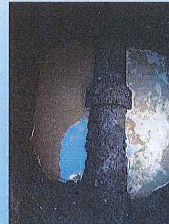
Reparación de fuga en línea de asbesto de 8" en la calle Abasolo Nte., esquina con Moctezuma Pte.
