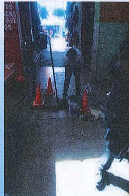
Sondeo a drenaje general del Mercado Pueblita.
