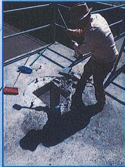
Retiro de anclas y soportes de los equipos del reactor biológico
