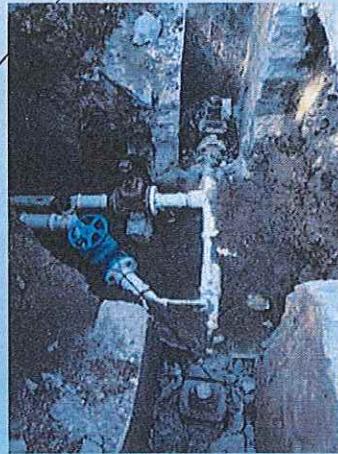
Colocación de válvulas de 3" y 2 ½" en el Fraccionamiento Las Lomas
