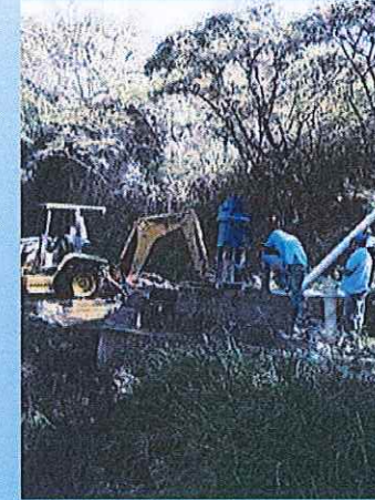
Instalación de equipo de bombeo y habilitación de represa en la convergencia de Dos Ríos para bombeo de agua de riego a La Garita
