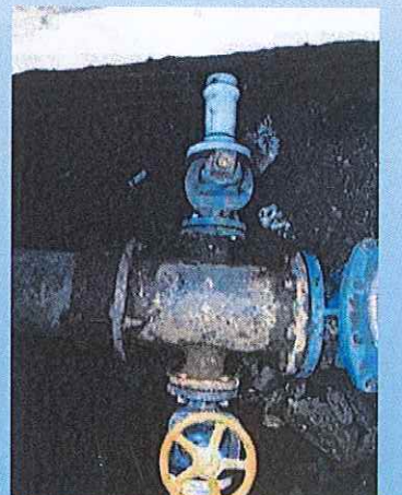
Cambio de segunda válvula de 3" en la calle Altamirano Nte., esquina con Sixto Verduzco.
