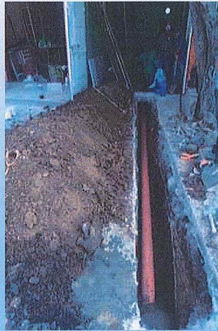
Rehabilitación de descargas domesticas en distintos puntos de la ciudad
