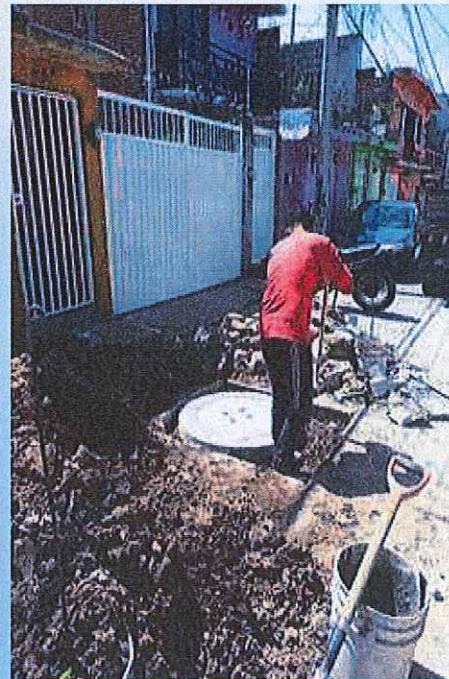
Construcción de pozo de visita en la calle Esperanza Olivares 93
