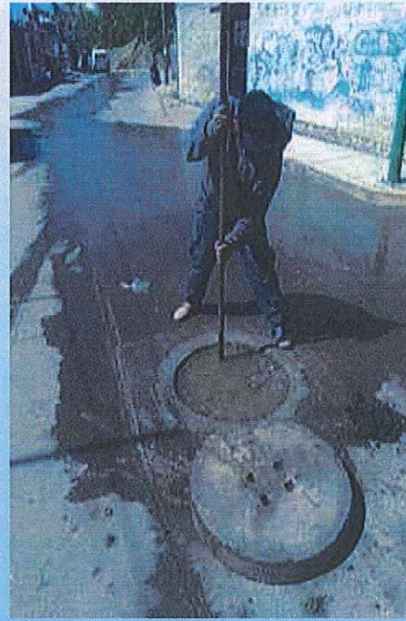
Desazolve de pozos de visita en distintos puntos de la ciudad
