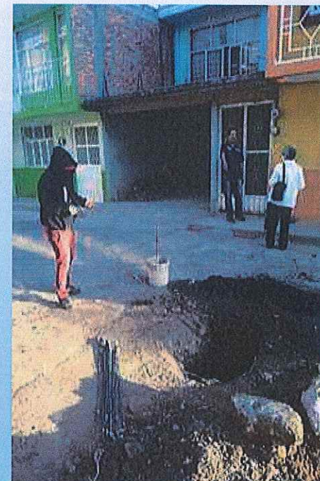
Sondeo a drenaje general por obstrucción en la Cerrada de Benedicto López Nte 4
